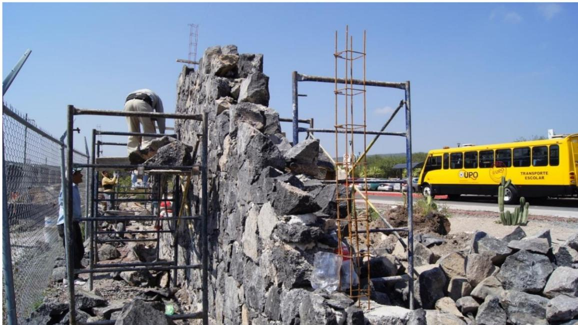
Figura 13. Barda perimetral durante de la construcción.
